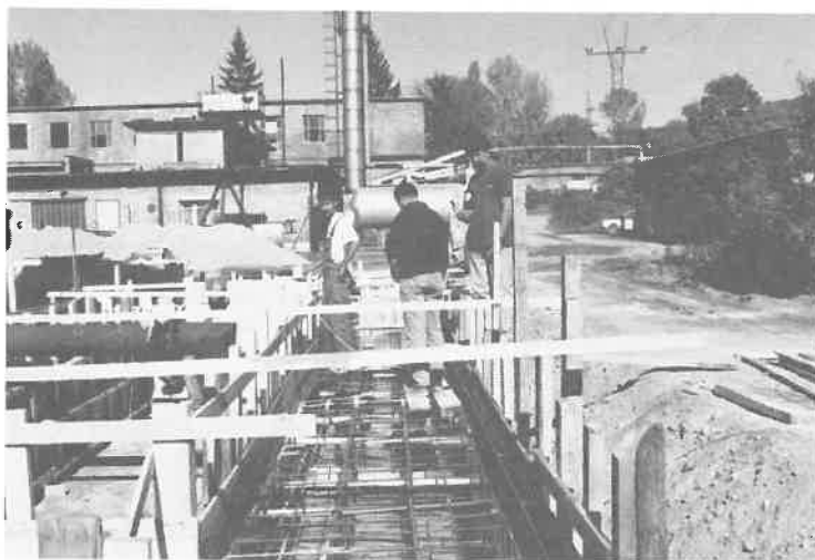
Vízkezelő üzem alapozása
